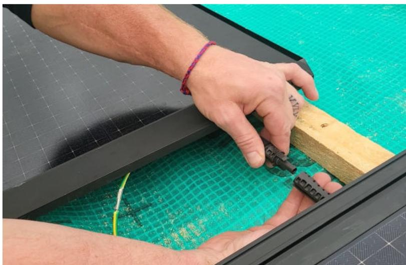
Al final de cada fila, se instala un cable de “enlace” de CC en un conducto flexible de alta resistencia hasta la siguiente fila, como se muestra en la imagen inferior.
