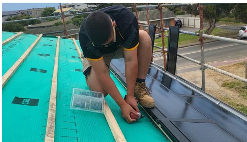
Las fijaciones deben atornillarse a través del canal en V situado en la orejeta del listón como se muestra a continuación, esto evitará que el tornillo se mueva después de golpear a través de la orejeta del listón de aluminio.
