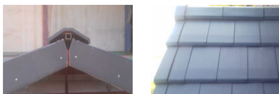
Instalación de Q120 con Teja Planum (TI)
