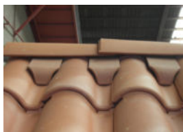
Instalación de Q02 con Teja Mixta (TG - TP)
