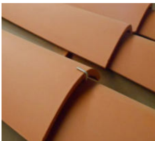
La separación entre tejas será de 20-50 mm
