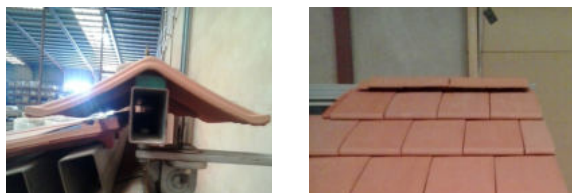
Instalación de Q90 con Teja Planum (TI)
