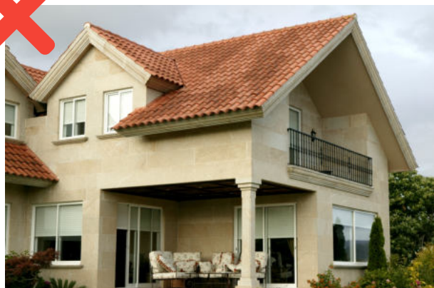
Problèmes d'humidité à cause d'une mauvaise ventilation
