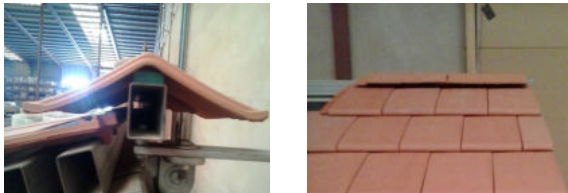
Mise en œuvre de la faîtière Atica Q90-Q110 (TI)
