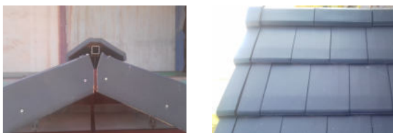
Mise en œuvre de la faîtière Q120 avec Planum (TI)
